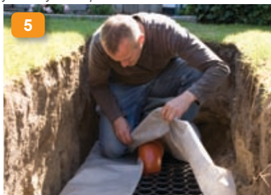
5: Fiberduken läggs nu noggrant omkring modulerna och anslutningsröret så att jord o.dyl. inte kan tränga in till BIO-BLOK® modulerna.
