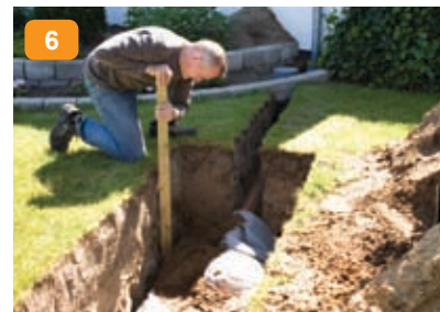
6: Närmast intill fiberduken läggs i möjligaste mån sand. Sand främjar vattnets förmåga att söka sig ut ur systemet samt skyddar fiberduken mot vassa föremål. Fyllnadsmaterialet skall stampas omsorgsfullt omkring och ovanpå systemet för att undvika sättningar. Använd eventuellt ett smalt föremål för att komma åt.
