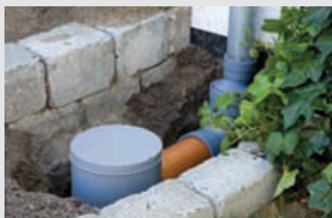
5: Fiberduken läggs nu noggrant omkring modulerna och anslutningsröret så att jord o.dyl. inte kan tränga in till BIO-BLOK® modulerna.
