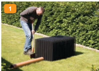
1: Placera ut BIO-BLOK® modulerna på marken. Märk ut och påbörja utgrävningen för anslutningsrör och dagvattensystem. Var uppmärksam på att frostsäkert djup ligger på från 75 cm. Anslutningsrörets fall 1 cm/m. Gräv 10-15 cm bredare och längre än den yta systemet upptar.
