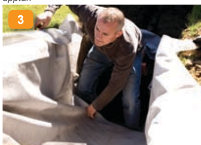
3: På plant underlag läggs fiberduken ut i botten av den grävda gropen. Perforera eventuellt fiberduken i botten för att öka dagvattensystemets effektivitet och livslängd. Placera BIO-BLOK® modulerna ovanpå fiberduken så att nätrören står lodrätt. Undvik i möjligaste mån jord o.dyl. ovanpå fiberduken.
