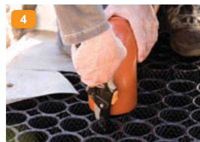
4: Röret ansluts enligt ett av alternativen nämnda här i broschyren. Hål för anslutningsröret klipps ut med t.ex. en sektör eller liknande för ändamålet. Vid anslutning från sidan klipps ca 10 cm längre in i modulen från rörets avslut.
